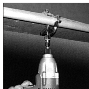
配管・配線支持金具取付
