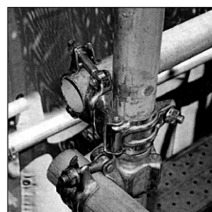
足場クランプの締め付け
