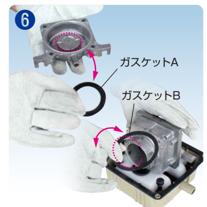
ガスケットA・Bを新しいものと交換する。
