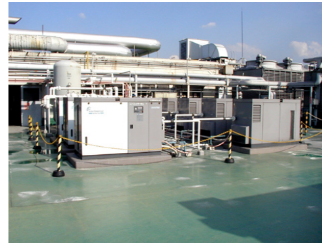
印刷工場(屋上設置) SMS37SD×7台
